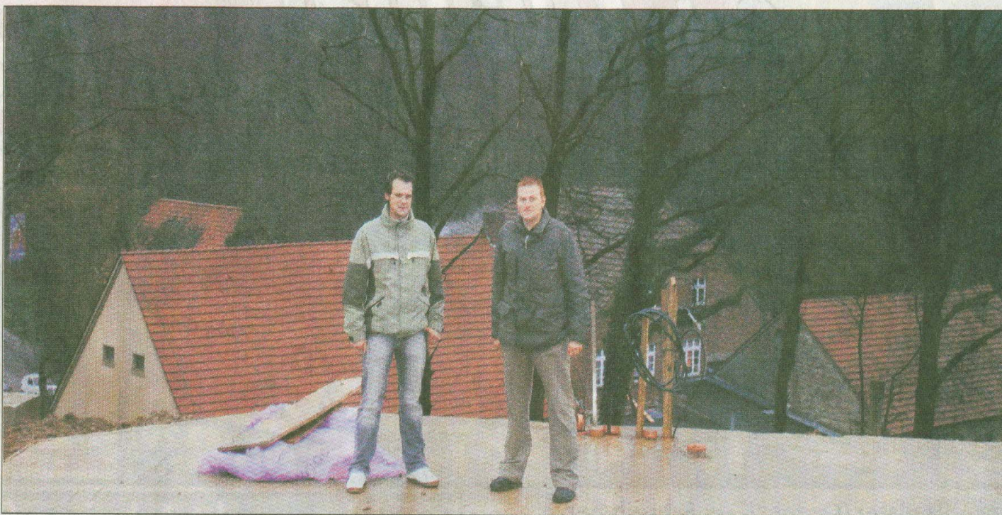
GUTE AUSSICHTEN: Ingo Hoogen (links) und Peter Dettmer wollen im Mai im Nettetale eine Minigolfanlage eröffnen. Das Fundament für das Verkaufshaus ist bereits gegossen. Foto: Claudia Lück
